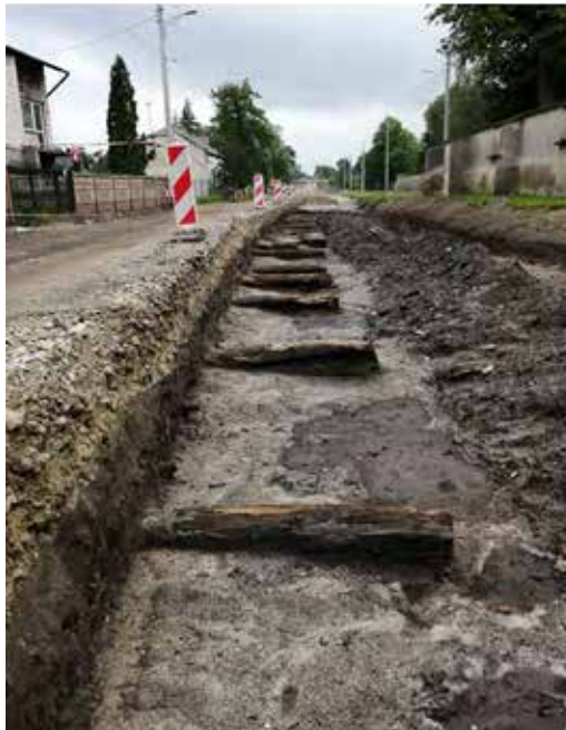
Ryc. 5. Kłody poprzeczne wzdłuż północnej krawędzi drogi 786, w jej zachodniej części. Fot. Z. Przepiórowski
