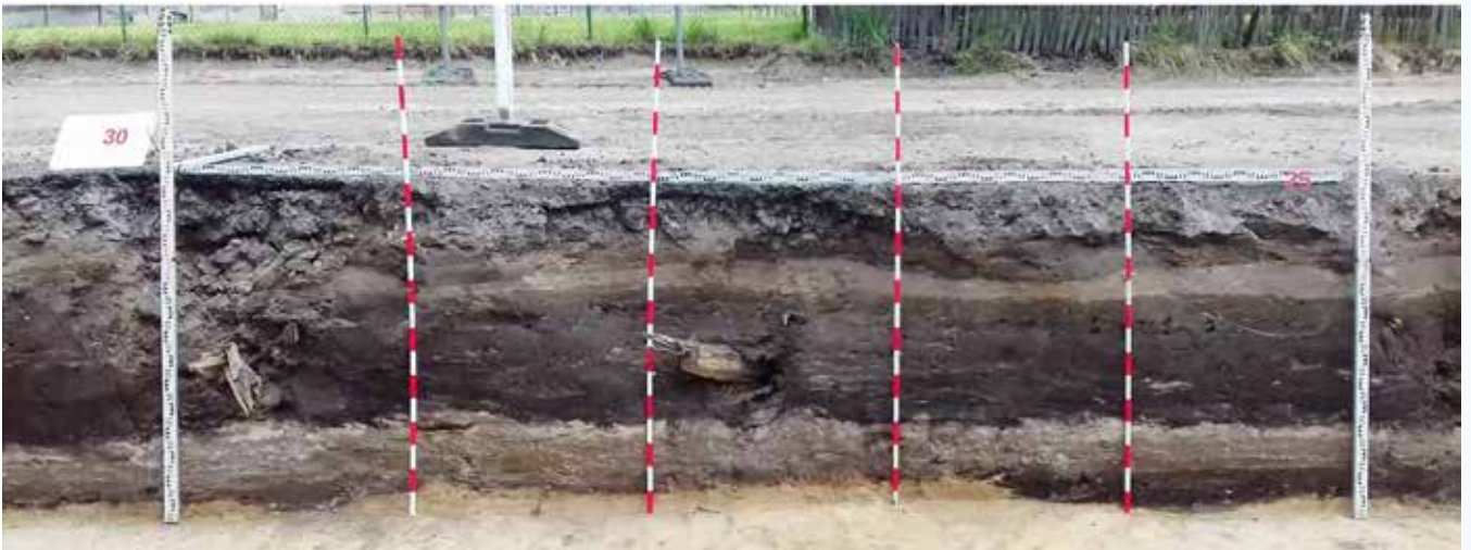
Ryc. 11. Fragment profilu północnego, z drewnianymi balami w części środkowej, warstwą organiczną, na której spoczywała drewniana konstrukcja i warstwą, która zalegała na balach drewnianych. Fot. Z. Przepiórowski
