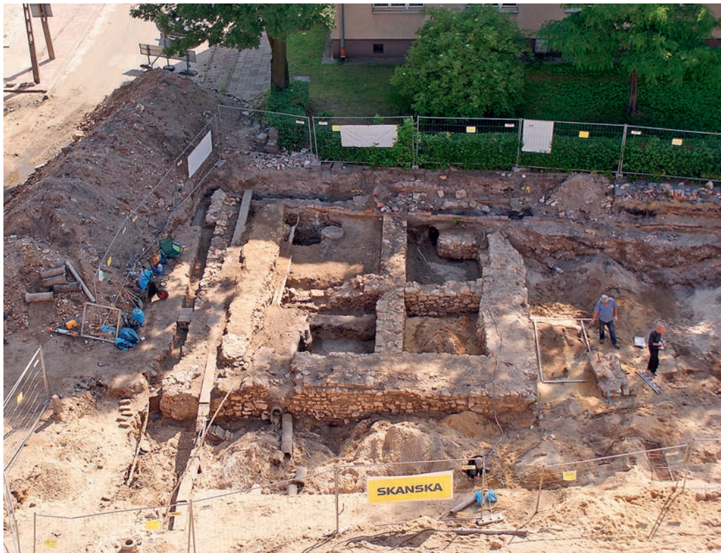
Ryc. 4. Widok z dachu domu przy ul. Nadrzecznej na fundamenty obiektu 1. Fot. Z. Małek
