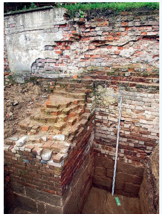
Ryc. 14. Mur fundamentowy skrzydła północnego klasztoru dominikanek na terenie Zespołu Szkół Ekonomicznych. Fot. M. Krakowski
