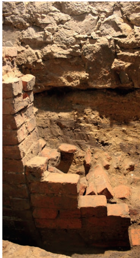
Widok na częściowo zamurowane wejście do krypty fot. Beata Badura
