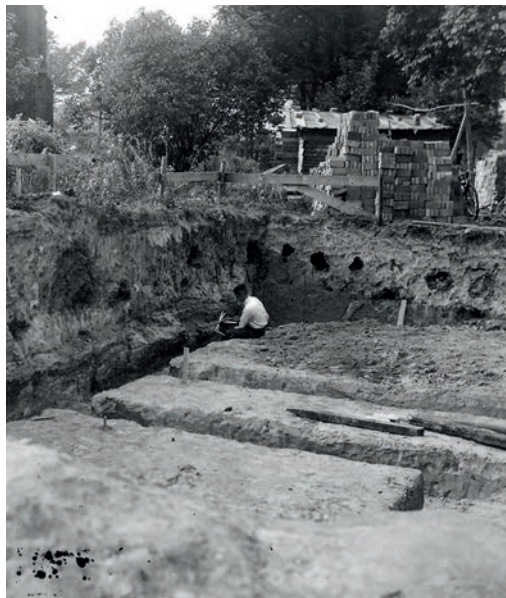
Wykopy pod fundamenty klasztoru Archiwum Działu Archeologii MGB fot. Georg Raschke
